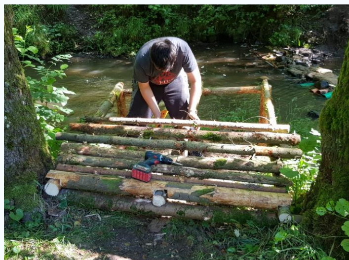
Schritt für Schritt entsteht die Brücke
