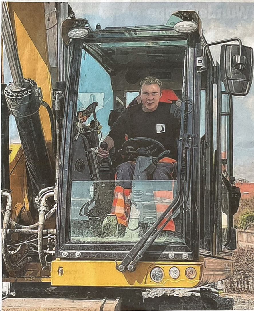
Leon Koppenhöfer bei der Arbeit auf einer Baustelle in Öhringen-Cappel.
